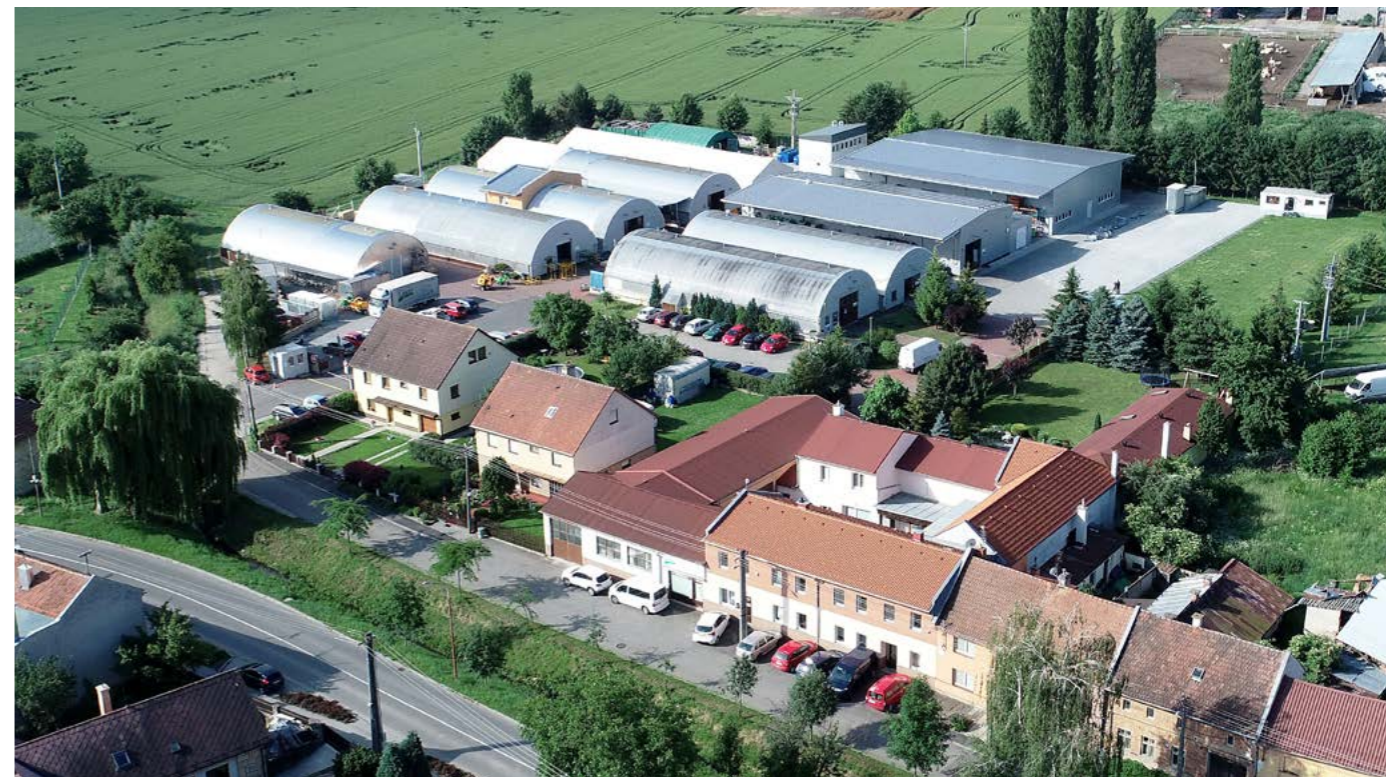
Areál firmy LASKI, s.r.o. 2020 / LASKI, s.r.o. Company Premises 2020
